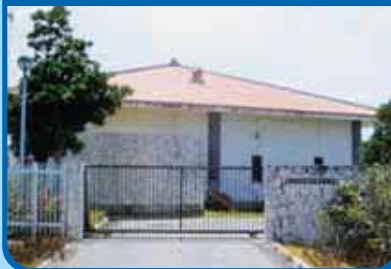
屋慶名汚水中継ポンプ場
