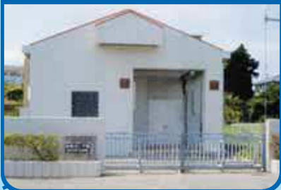
赤野ポンプ場
