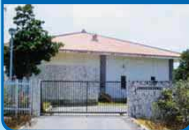
屋敷名汚水中継ポンプ場
