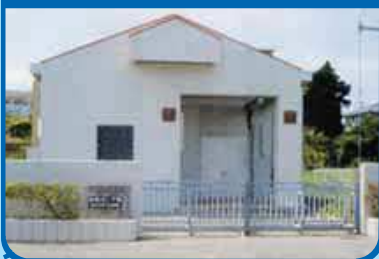
赤野ポンプ場
