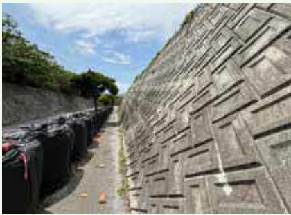
歩道に設置されたトン土のう袋
