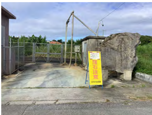
早期の利用開始が望まれる川田原貯水池ポンプ場
