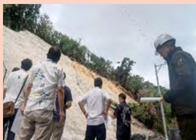
藪地島の被災状況について現場確認を行う様子
