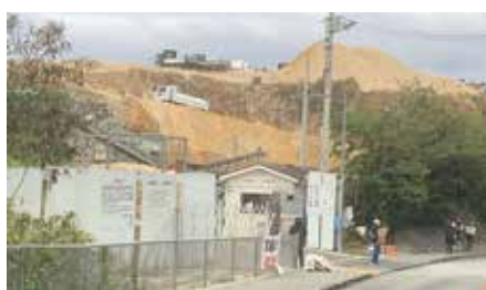
辺野古埋立用土砂の搬出が続く、宮城島にある採掘場
