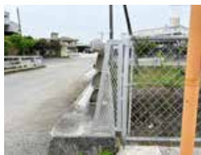
（新地橋）付近の安全対策された赤野橋
