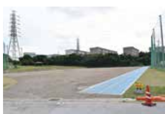
整備された具志川野球場サブグラウンド
