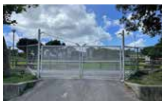
取替えが完了し、きれいになった門扉
