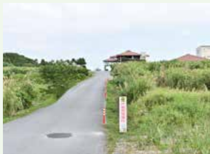
現状の株式会社ぬちまーすへ続くアクセス道路の一部区間
