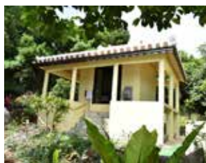
整備の完了した嘉手苅観音堂
