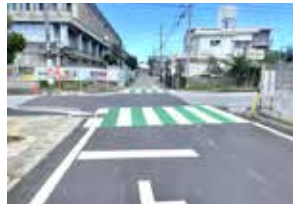
西原区自治会からの要請を受け安全対策を実施
