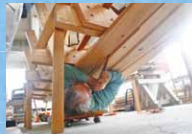
摺り合わせの作業 板と板とを密着させるため鋸をひきます。
