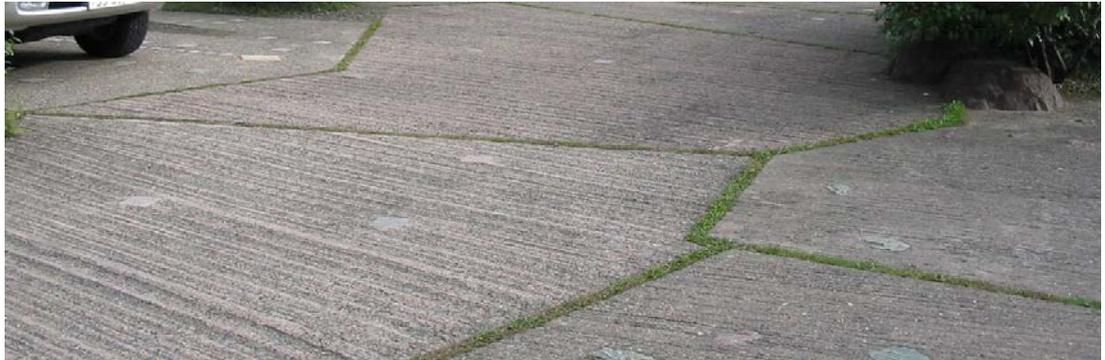
【舗装材の見切りを設けた事例\_※コンクリート舗装】
