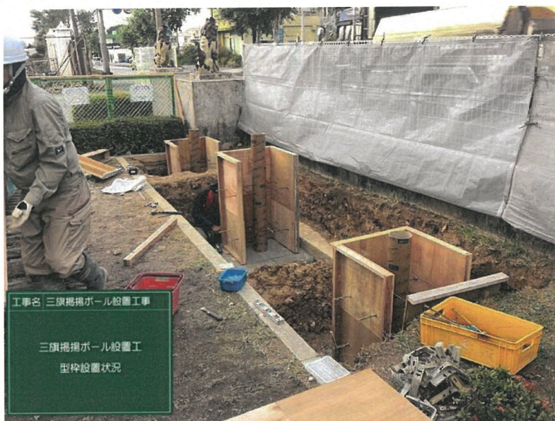
三旗掲揚ポール設置工 基礎型枠建て込み状況
