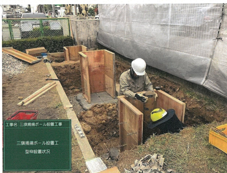
三旗掲揚ポール設置工 基礎型枠建て込み状況
