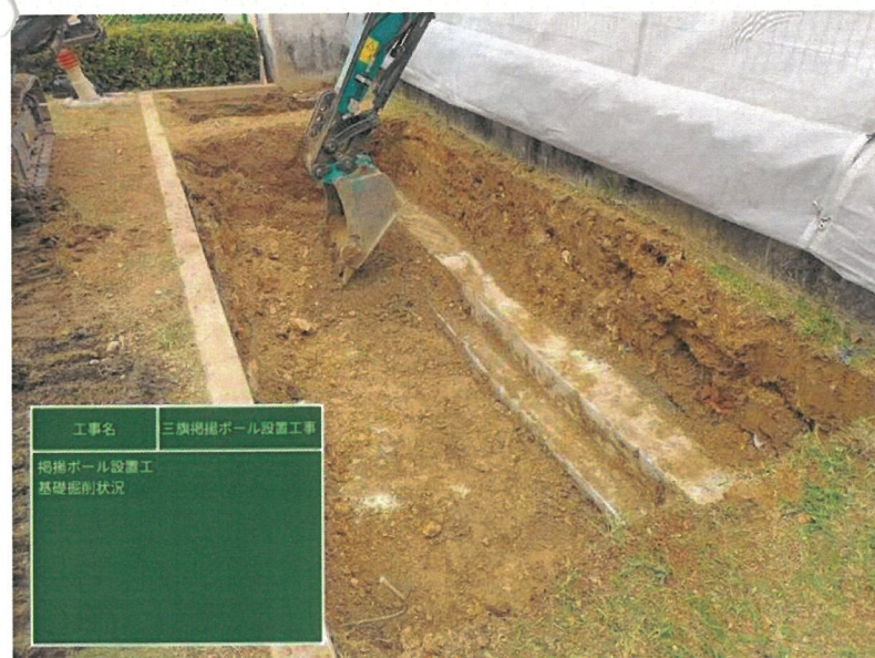
三旗掲揚ポール設置工 基礎根切り状況
