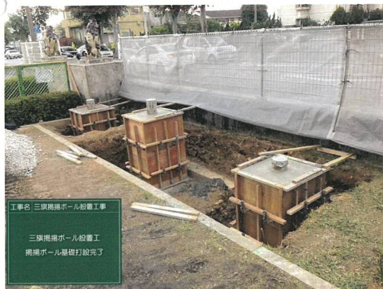
三旗掲揚ポール設置工 基礎コンクリート打設状況
