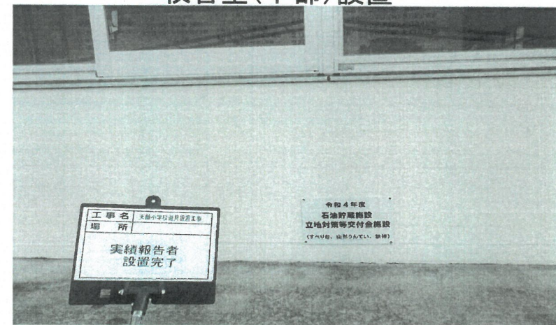
校舎壁(下部)設置
