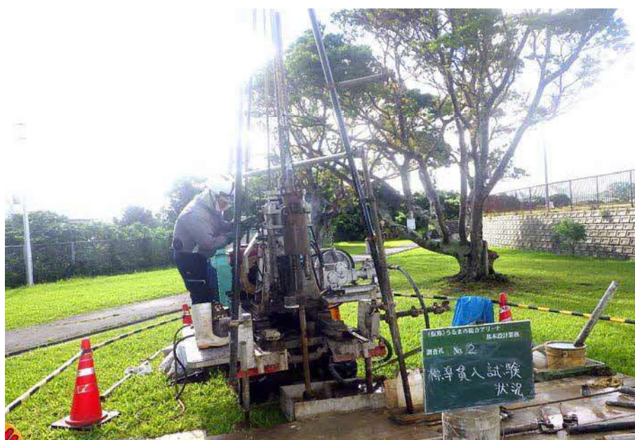
標準貫入試験状況
