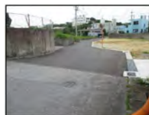
↑上江洲塩屋線 (狭い箇所の拡幅)
