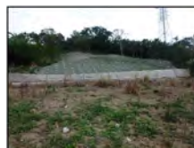
宮里 6-56 号線 (法面整備)
