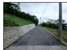
↑宮里 6-56 号線 (道路整備)
