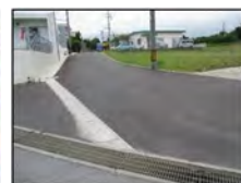
↑上江洲 5-10 号線 (側溝整備)
