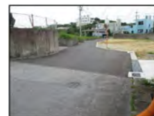
↑上江洲塩屋線 (狭い箇所の拡幅)
