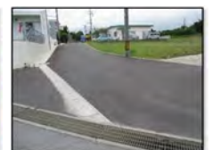
↑上江洲5-10号線 (側溝整備)
