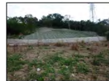
宮里6-56号線 (法面整備)
