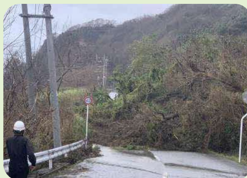
台風6号に伴う宮城島土砂災害による通行止め (令和5年8月6日発生)
