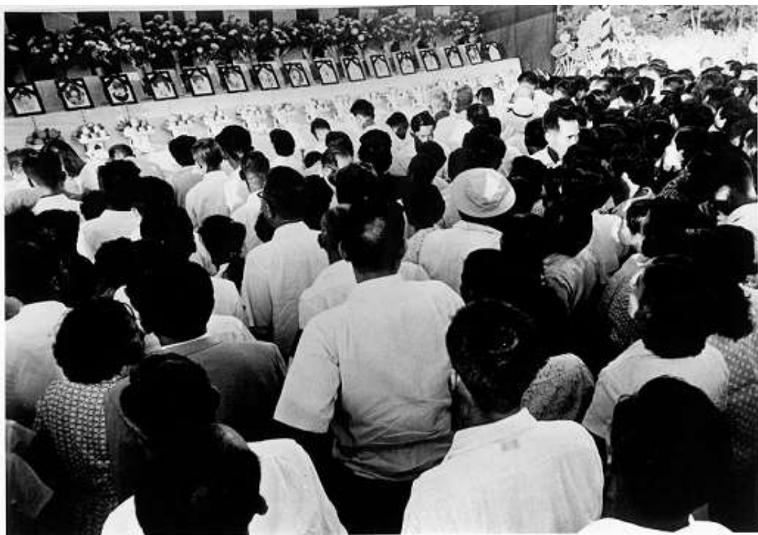
犠牲者の合同慰霊祭 宮森小学校（17 柱） 昭和 34（1959）年 7 月 27 日
