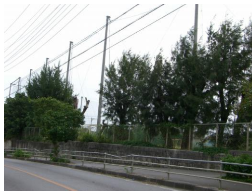
与勝中学校防球ネット設置
