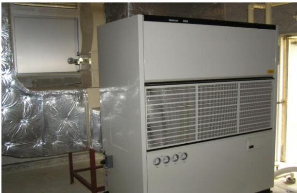
伊波小学校空調機器復旧工事
