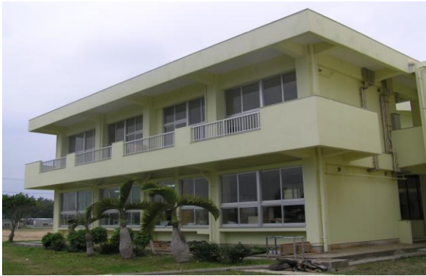
平安座小中学校改造防音工事
