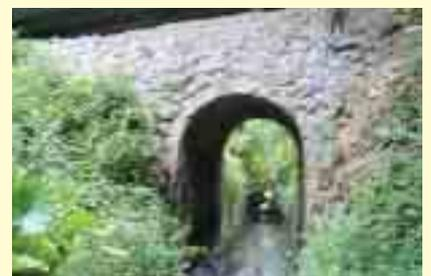
昭和3(1928)年の大典記念(昭和天皇の即位記念)の年、ガーラー山を切り開いてガーラ川に架けられたアーチ型の石砦。長さ5m、幅2m、川底からの高さ5mに架設されており、上に重圧がかかるほど、橋は頑固になっていくといわれています。
