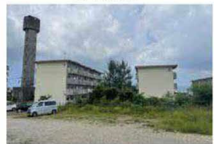
県営石川団地
