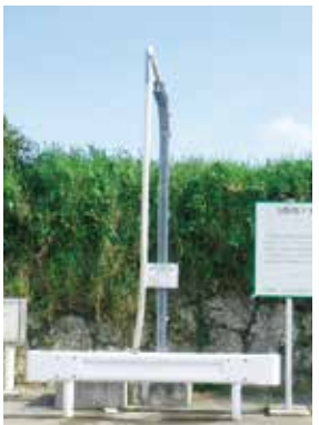
【設置している給水所】
