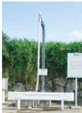
【設置している給水所】
