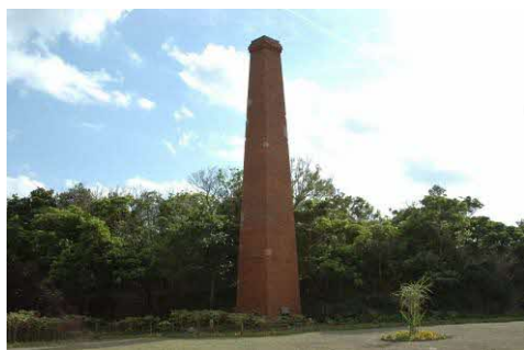
平敷屋製糖工場跡
