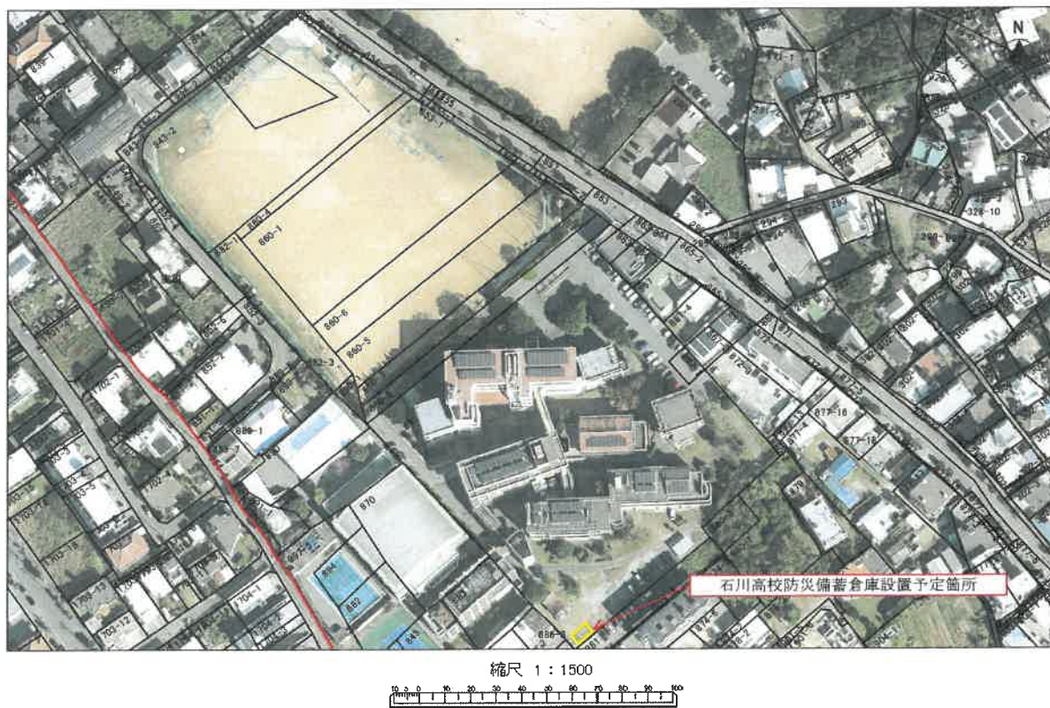
石川高校防災備蓄倉庫設置予定箇所（遠景）
