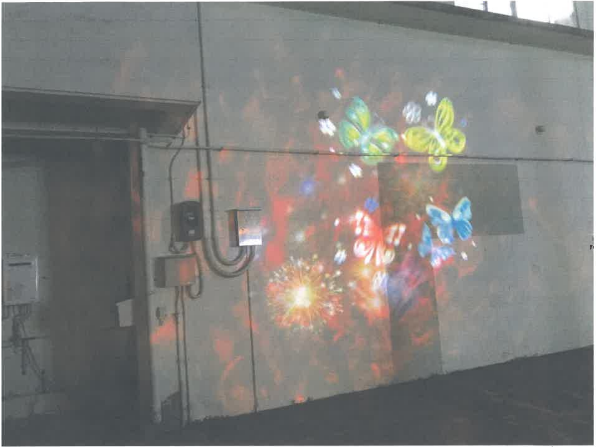
徳田土木設計・アキカシオン システム設備
