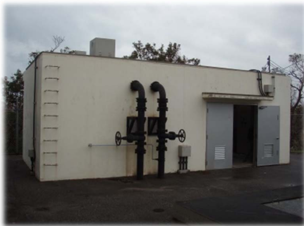
【石川地区】警察学校前ポンプ場
