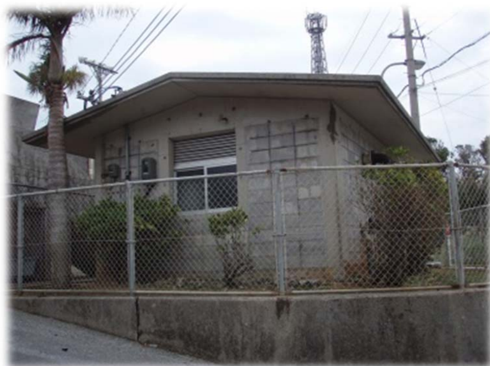
【勝連地区】平安名ポンプ場
