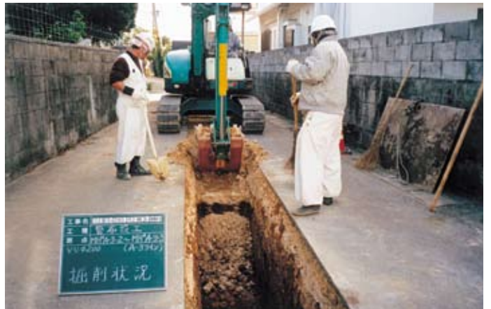
市内各地域で行われている下水道整備事業
