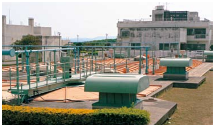
増設工事が予定されている石川終末処理場
