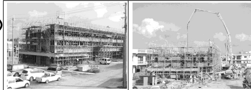
写真：改良住宅B棟、C棟建設現場の様子
